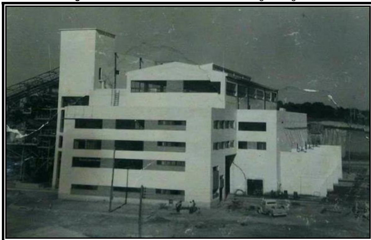
Figura 24– Usina sendo concluída... A energia chegou!
